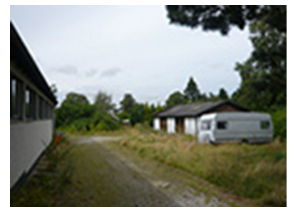
Det er en forbedring for området at den tidligere erhvervsejendom nedrives og der opføres boligbebyggelse i lokalplanområdet, både med hensyn til fjernelse af jordforurening og til forskønnelse af området .
